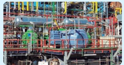
A WEG realizou um importante fornecimento para a Cepsa que inclui um motor à prova de explosão com refrigeração por tubos carga 900 K/J, que alimentará um compressor recíproco de uma unidade de recuperação de gás hidrogénio, na refinaria de La Rábida, localizado em Palos de la Frontera (Huelva - Espanha).
