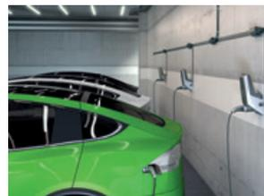
A solução de distribuição de energia por cabo planar podis®, da Wieland Electric, é ideal para a alimentação de estações de carregamento de veículos elétricos. Este sistema descentralizado permite que um grande número de carregadores seja ligado a apenas um cabo de
